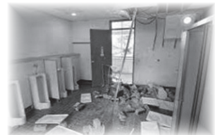
[그림 4] 화장실 천정 파손
